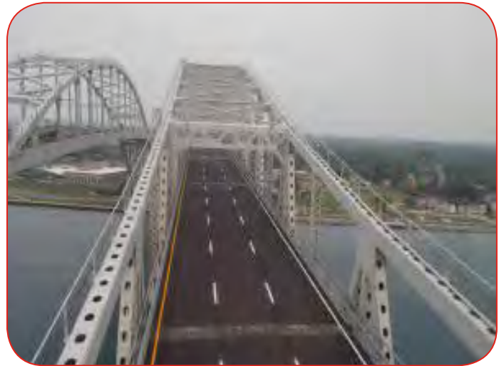
Vue aérienne des ponts canadiens et américains du pont Blue Water à Point Edward
